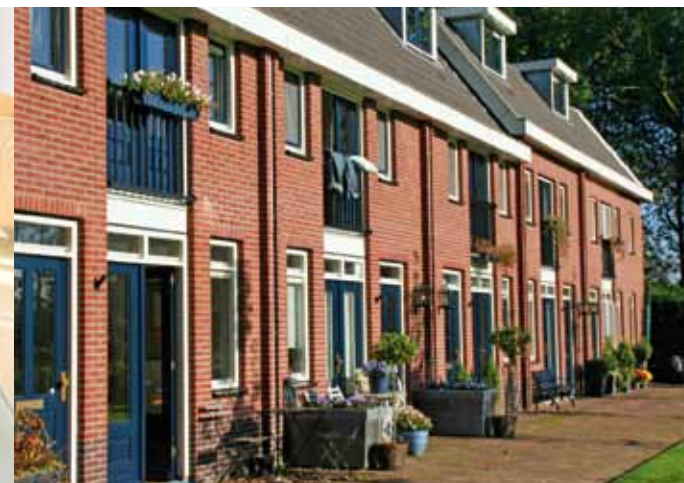
Monovalente configuratie in nieuwbouwwoningen.
